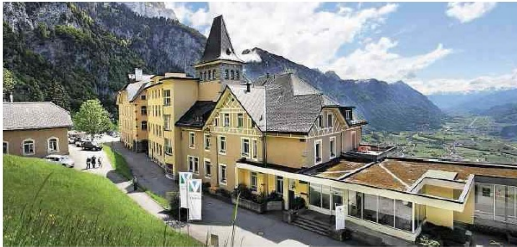
Die Rehabilitationsklinik Walenstadtberg hoch über dem Seeztal.
